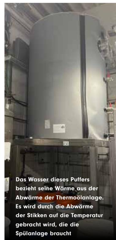
Das Wasser dieses Puffers bezieht seine Wärme aus der Abwärme der Thermoölanlage. Es wird durch die Abwärme der Stikken auf die Temperatur gebracht wird, die die Spülanlage braucht
