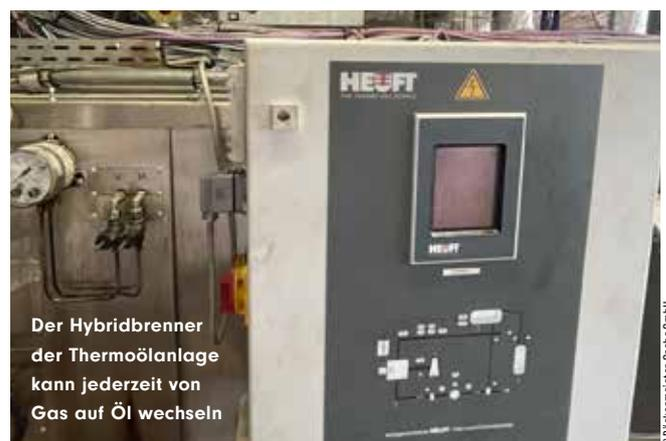
Der Hybridbrenner der Thermoölanlage kann jederzeit von Gas auf Öl wechseln
